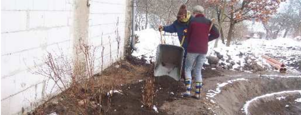
Rund um den Teich wird Muttererde aufgetragen.
