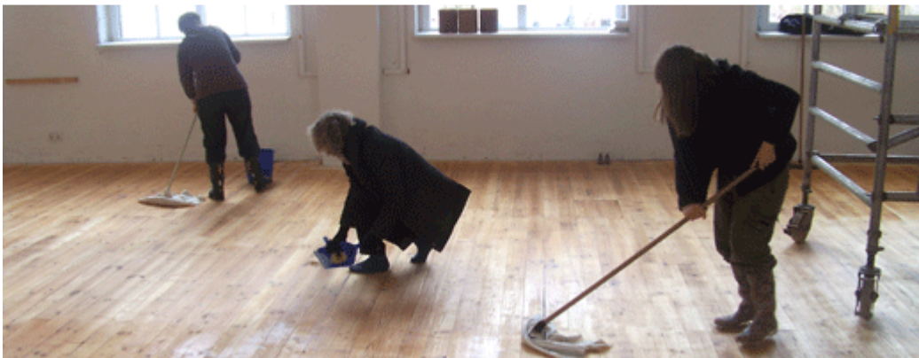
Reinigung des abgezogenen Fußbodens – kann er noch versiegelt werden?
