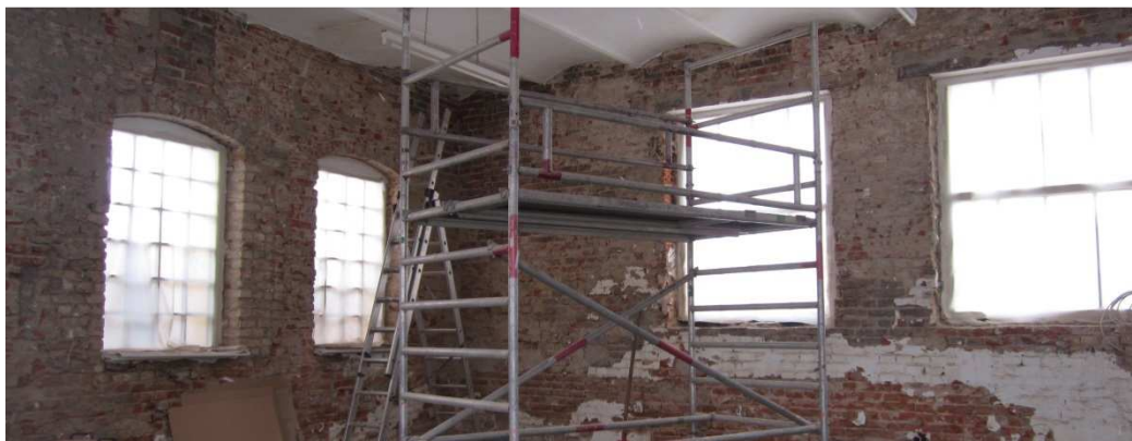
... während tagsüber der Putz in den Ausstellungsräumen abgeschlagen wurde
