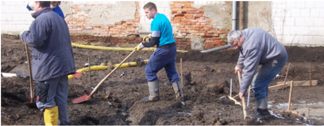
Arbeiten im Schlamm am neuen Teich
