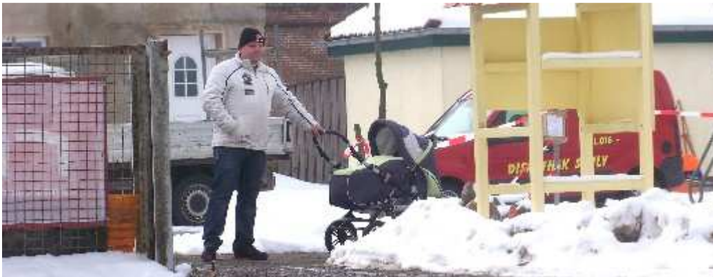
Das öffentliche Interesse an den Bauarbeiten wächst ständig.
