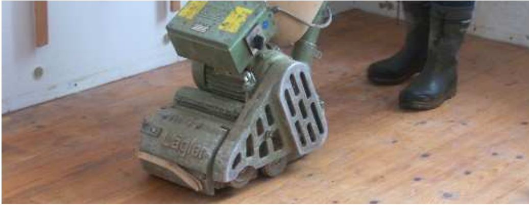
In der großen Ausstellungshalle wird der Fußboden abgeschliffen.
