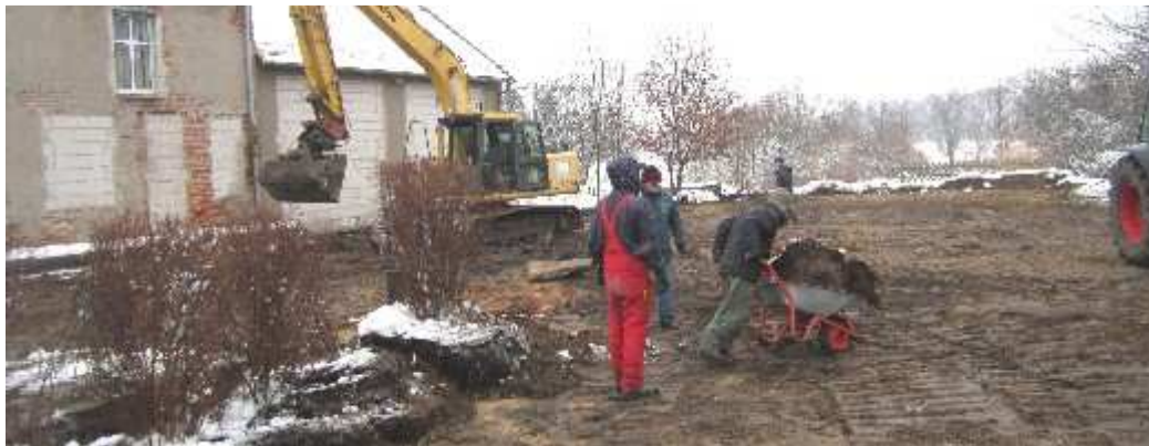
Eine Hecke muss versetzt werden.
