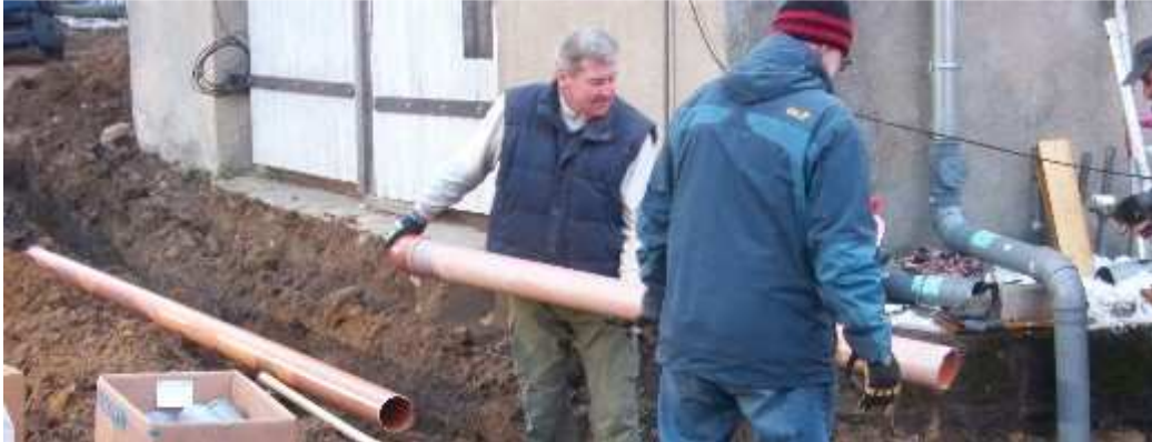
Regenwasser soll in den Teich fließen ... dazu gehören Rohre.
