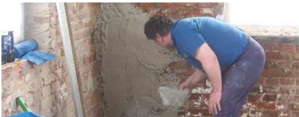
Das Verputzen in den Ausstellungsräumen geht voran.
