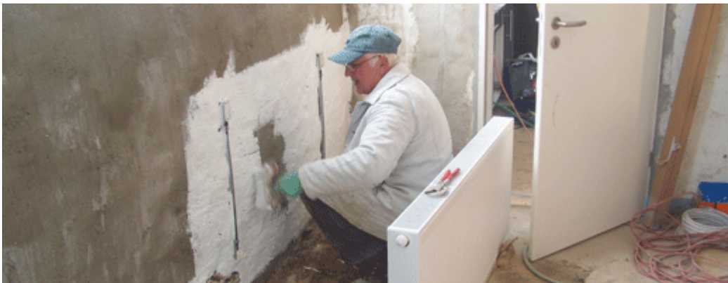
Montage der Heizkörper
