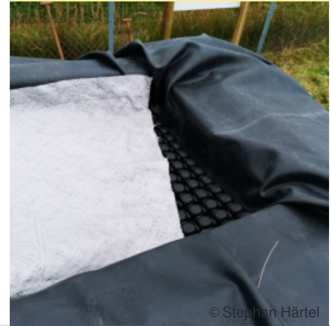
EPDM-Folie und Drainage
