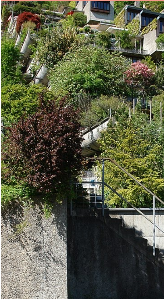
TERRASSENSIEDLUNG MÜHLEHALDE UMIKEN, SCHWEIZ | 1963-71 SCHERER, STRICKLER + WEBER | METRON
