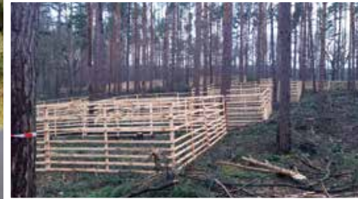
Am Plötzensee (links), Einbau von Sohlerrhöhungen am Schlangengraben (oben), Waldumbau am Plötzensee (unten)
